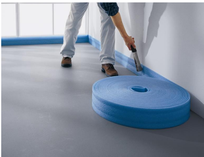
PE-Randdämmstreifen
